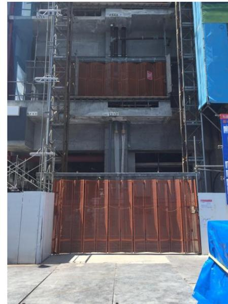
\* 組立て時はP C班による工程の中での必要部材を各フロアに先行搬入し、無駄な人員削減を行い、またクレーン解体は狭い敷地の為、縦吊解体を行った
