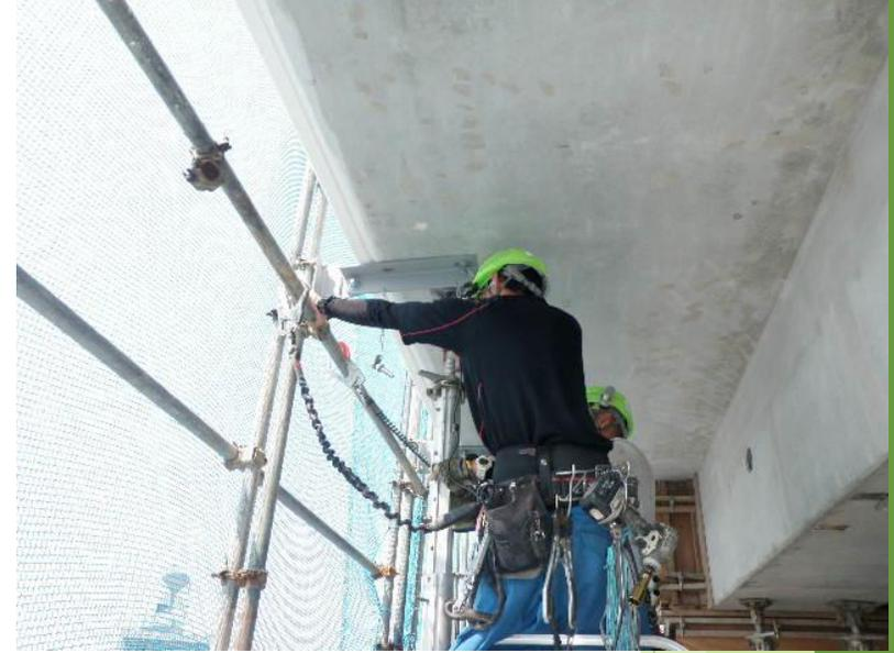
\* 既製品ではなく強度計算された、単管・クランプ・ブレスによるユニット化で資材経費の削減
